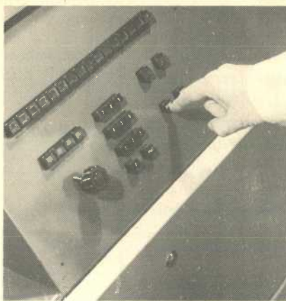
Bedienings/controle-paneel van de automatische röntgenspectrograaf. Behalve de startknop is een knop voor nulinstelling gemonteerd waarmee de analysecyclus indien gewenst beëindigd kan worden. De vier en vijftien signaallampjes geven aan, welke van de vier preparaten wordt geanalyseerd in welke van de vijftien geprogrammeerde hoekposities.
